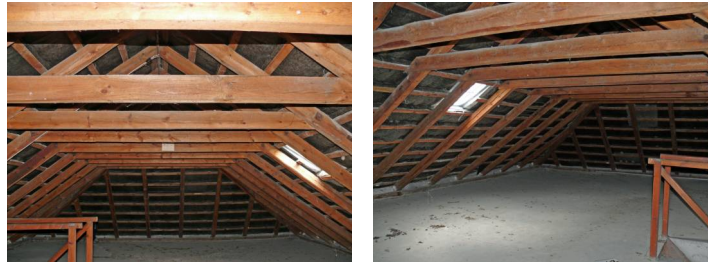
Der Dachboden vor dem Ausbau
