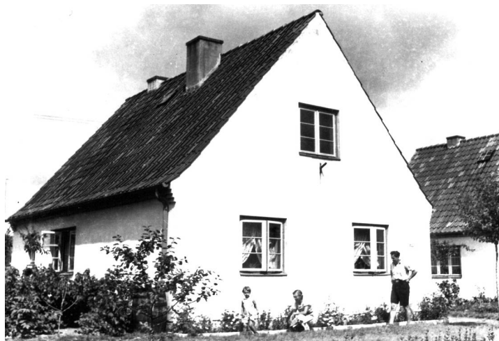
Der Bewuchs ist dichter geworden, Dachgeschoss ist noch nicht ausgebaut (Foto Witzke)
