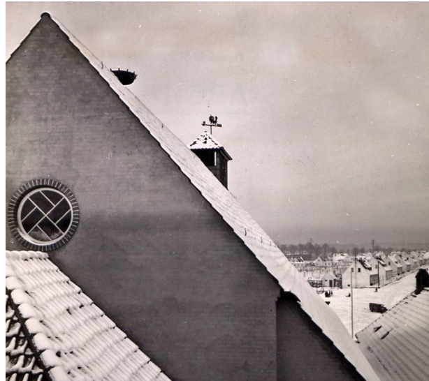
Aufnahme vom hinteren Quergebäude der Schule mit Sicht auf die Straße Rangenberg/Ecke Siemser Mühlenweg * 4
