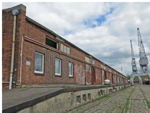
Abbildung 15: Schuppen F, äußerlich unterscheidet sich der Schuppen F nicht wesentlich von den anderen Schuppen. In dem Betonkeller sind in der Rampe die Luken zu erkennen. Außerdem ist die obere Fensterreihe ganz anders gestaltet, 2024
