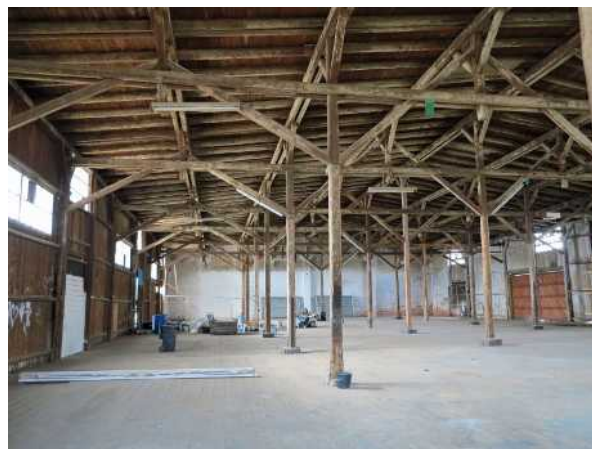
Abbildung 10 Das Innere des Schuppens, die Räumlichkeiten sind unterteilt, der Boden ist teilweise aus Holzplanken. Das Dach und die Ständer mit den Trägern sind im ursprünglichen Zustand und gut erhalten, 2024
