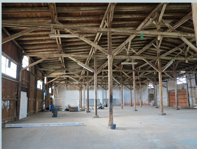
Innenansicht eines Segments. Ähnlich sind die Schuppen B, C, D mit der Dachkonstruktion auf- gebaut. Es darf nicht vergessen werden, das die gesamte Dachkonstruktion vor 120 Jahren gebaut worden ist und die Jahrzehnte überstanden hat.
