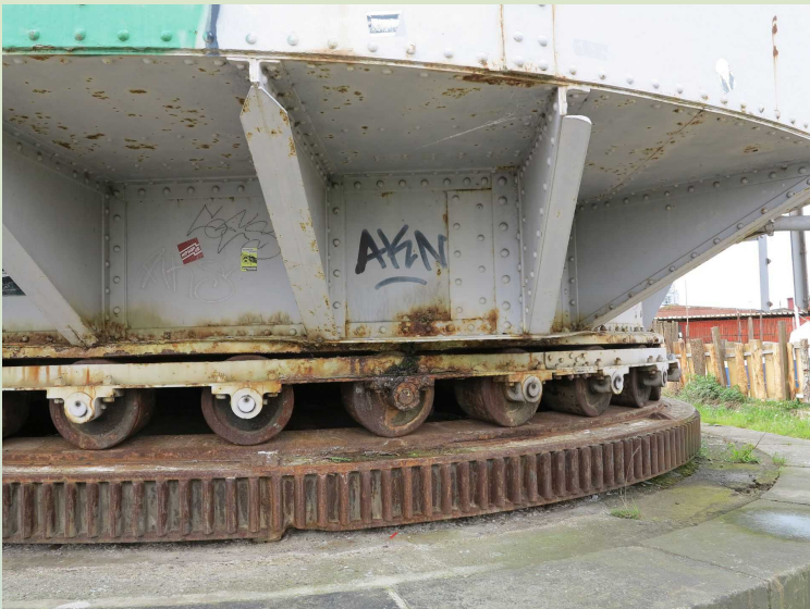
Der Kran steht auf einem Sockel auf Rollen.
