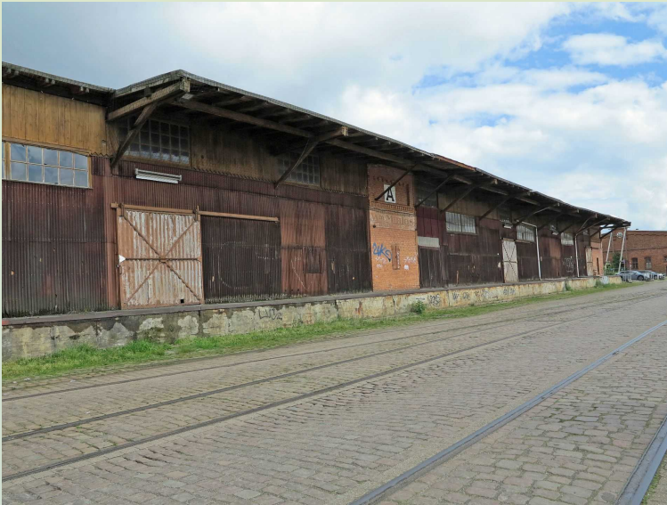
Der nördliche Teil des Schuppen A Im Hintergrund ist die Stirnseite vom Schuppen B zu sehen.
