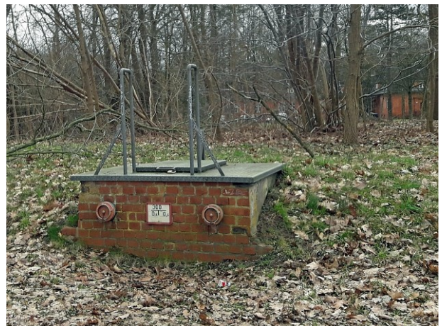
Zapfstelle, vermutlich für Treibstoff, sieht nach bestehender Nutzung aus
