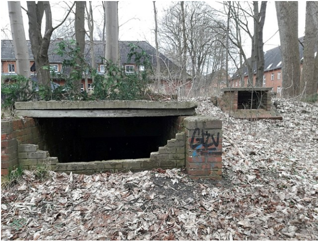
Erdbunker Nähe der Mannschaftsunterkünfte
