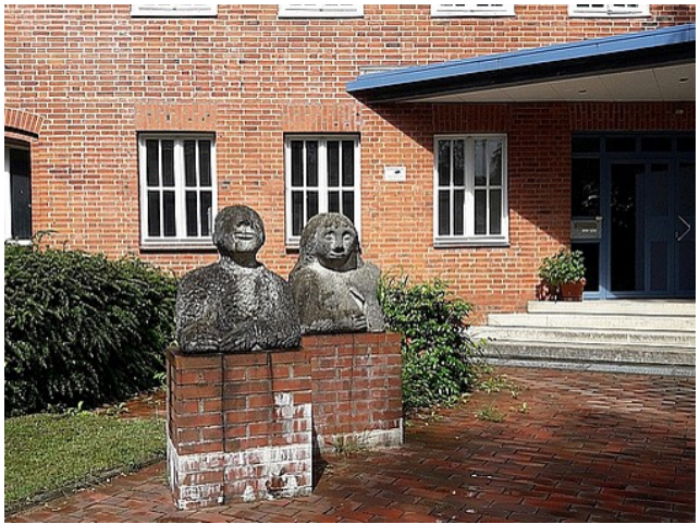
Der Haupteingang zur Innung Baugewerbe
