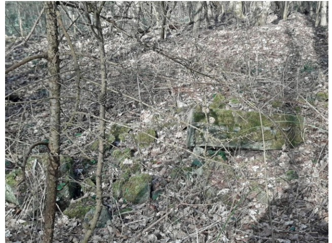
Vertiefungen im Boden und Betonteile
