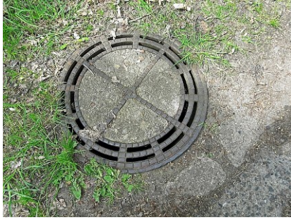
Kanalisation auf dem Gelände
