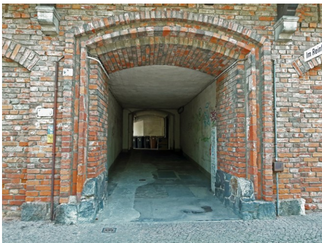
Durchgang von der Straße
