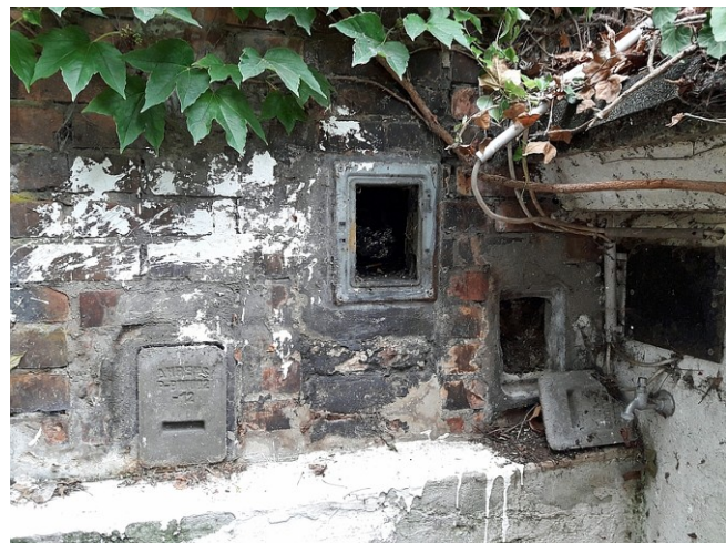
Kaminschächte an der rückwärtigen Wand
