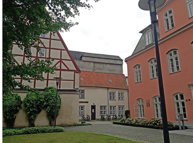
Die längsseitige Bunkerwand vom Hof der Gebäude Schildstr. 12-16, der Bunker überragt das Hofgebäude
