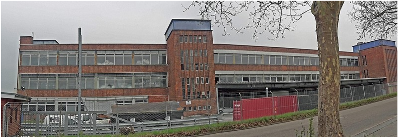
Ehemals Berlin-Lübecker-Maschinenfabriken (BLM), Glashüttenweg 33-35, Dornier-Werke, kurz vor dem Abriss, die Gebäude sehen intakt aus.
