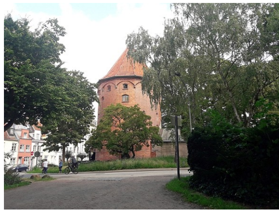
Ansicht aus südlicher Richtung
