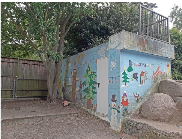
Neue Eingangstür zum Bunker
