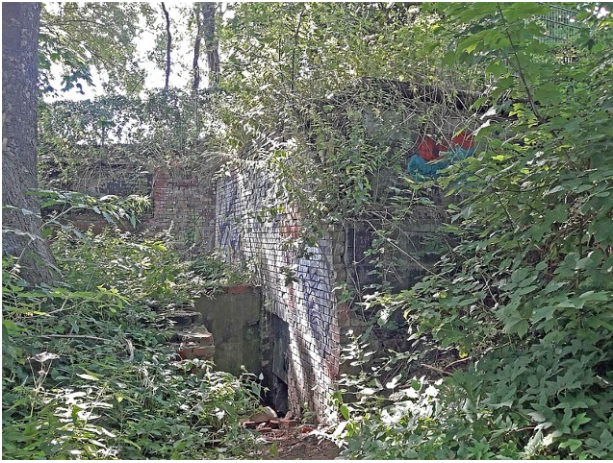
Geschlossener Eingang des Bunkers
