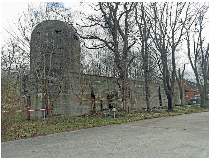
Massiver Bunker, der einen Schießstand im Längsgebäude beinhaltet, der Turm diente der Beobachtung des Fliegerhorstes, unter runden Kuppel sind die Beobachtungsscharten zu erkennen
