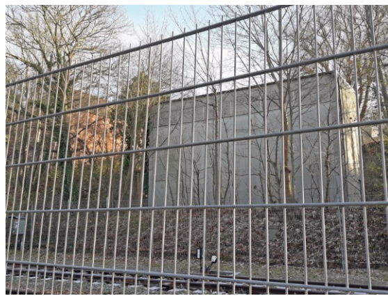
Hochbunker (?) am Ende der Bunkeranlage, heute Umspannwerk St. Gertrud der Stadtwerke
