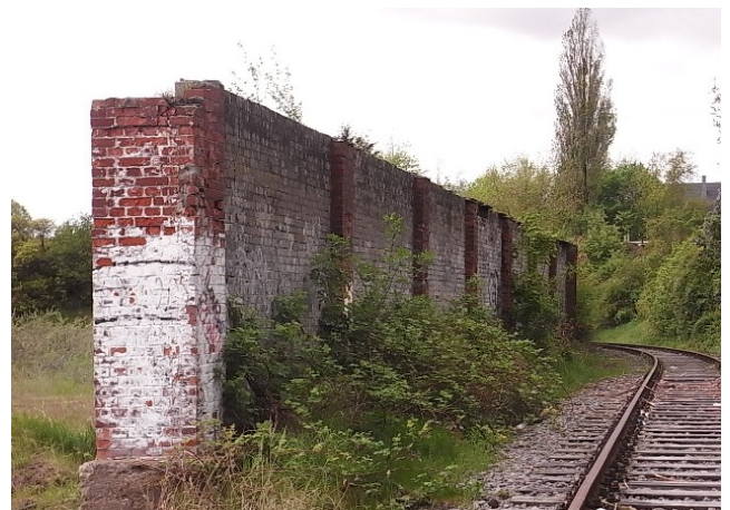
An einer besonders engen Stelle wurde eine Mauer errichtet
