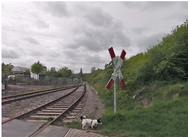
Das abfallende Gelände an den Gleisen
