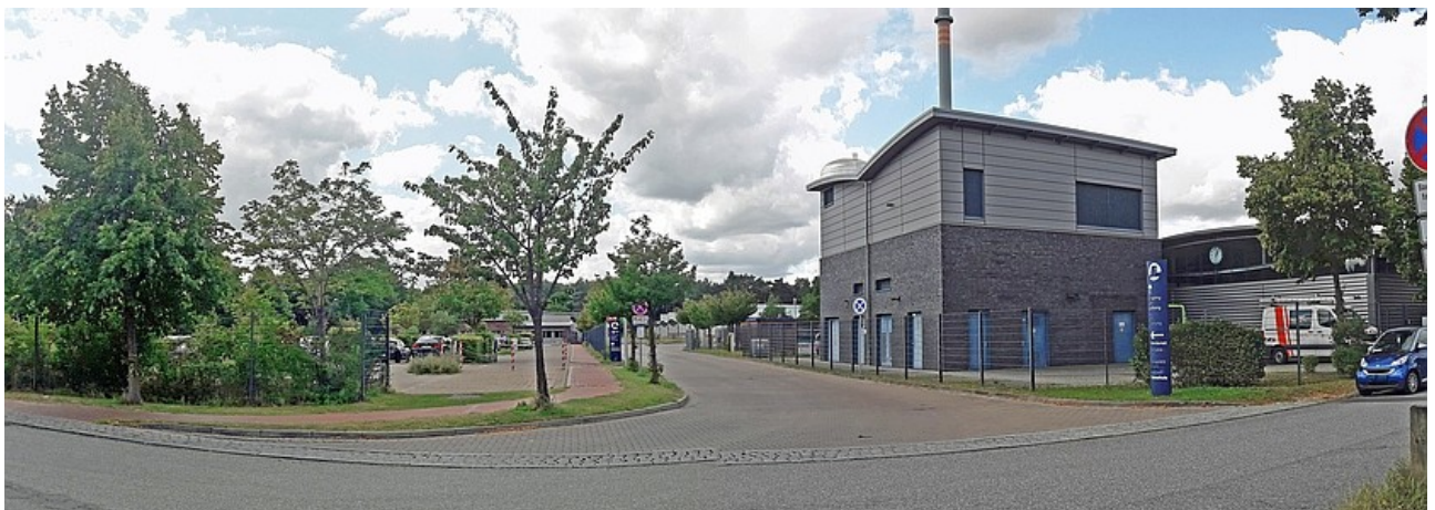
Eingang Betriebshof Stadtwerke-Verkehr von Ratekauer Weg
