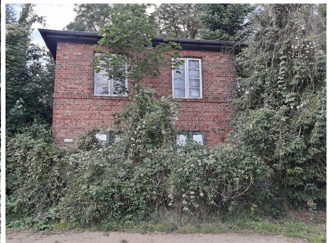
Rechts daneben, vormals Wallhalbinsel 39, Anfang 2026 abgerissen
