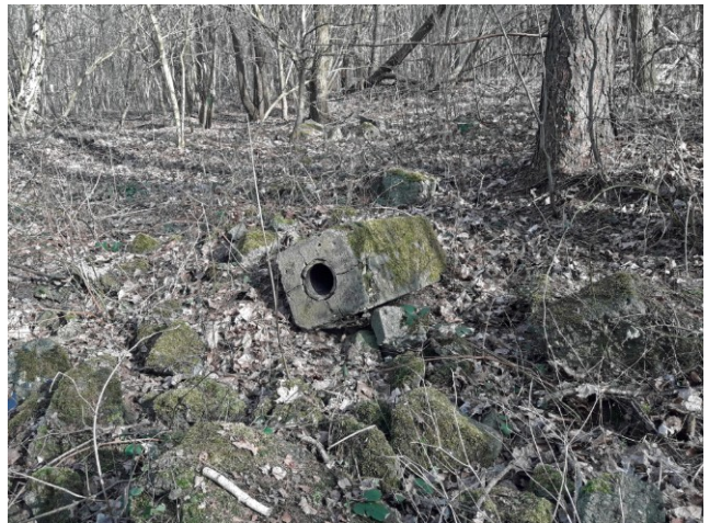
Teil sieht aus wie eine mit Beton ummantelte Röhre
