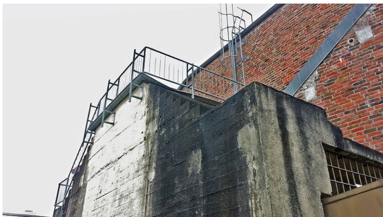
Großer Eingang des Bunkers und umlaufende Treppe zum Dach
