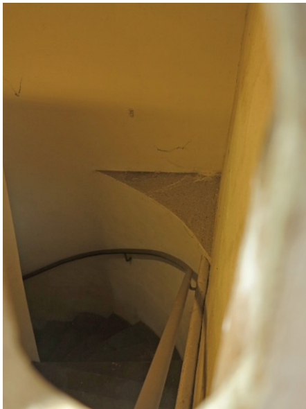
Ein Abgang in das Kellergeschoss
