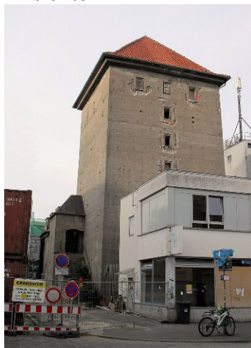
Der Bunker vor dem Abriss*
