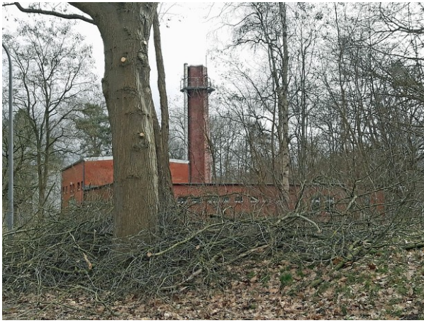
Blockheizwerk, offensichtlich in Nutzung
