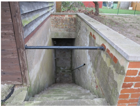
Ein Kellereingang von außen, vom Hof aus
