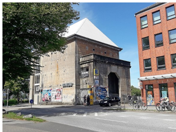
Bunker- Eingang (auch Disko-Eingang)
